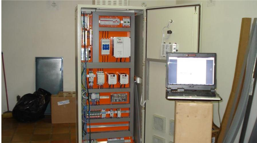
**Figura 40 – Painel em fase de Parametrização dos inversores e Soft-starter.**
