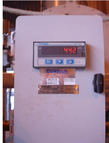
**Figura - 02 Indicador de vazão de Gás**
